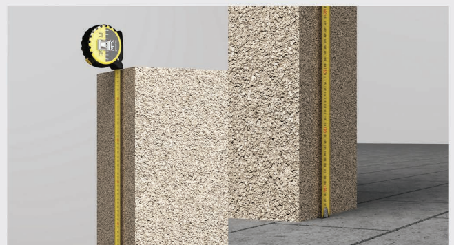
6 Prendre la hauteur des 2 piliers, retenir la plus petite mesure et déduire 7cm pour la fixation des éléments de guidage; Measure the height of the two pillars. Consider the smallest height and deduct 7 cm for the installation of the fixing elements;
