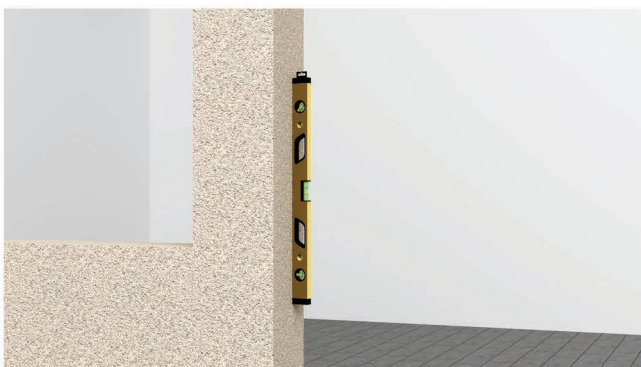
2 Contrôler les niveaux des 2 piliers; Control the straightness of the pillars;
